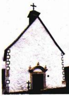
Izgled crkve u tijeku radova, kada je obnovljen pokrov hrastovom šindrom, a još vidljivi tragovi dograđenog trijema i ulazno pročelje po završetku sanacije i konzervatorsko-restauratorskih radova
