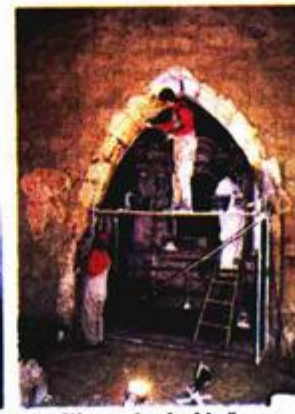
Restauratorski radovi na gotičkom luku i zidnom osliku te izgled južnog pročelja nakon radova obnove
